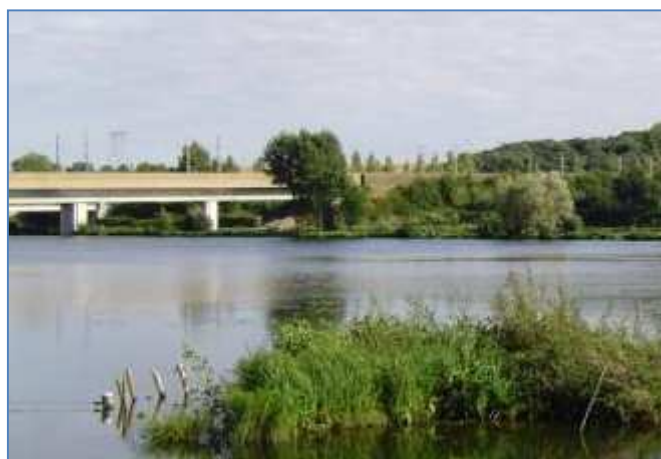
Viaduc de la Somme au dessus des étangs de la Haute Somme à Feuillères, passage du TGV et de l'A1
